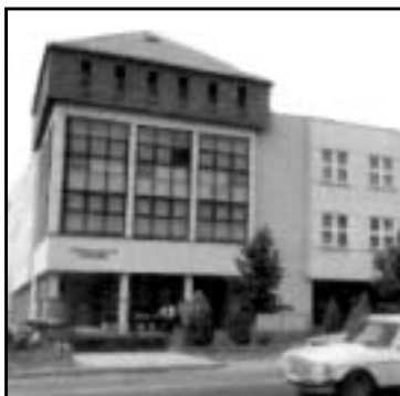
A kollégium épülete
